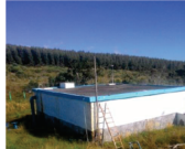
Figura 07 - Reservatório C2 - Três Bocas
