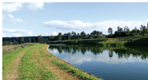
Figura 10 - Lagoa de estabilização da ETE
