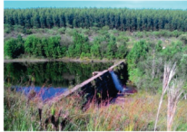
Figura 06 - Captação Ribeirão Três Bocas
